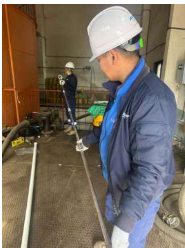
Наращивание датчика DUT-E до 8 метров
